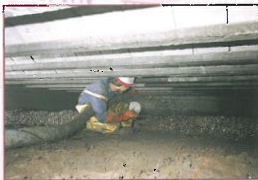
Het aanbrengen van isolatieschelpen. Foto: Isoschelp
