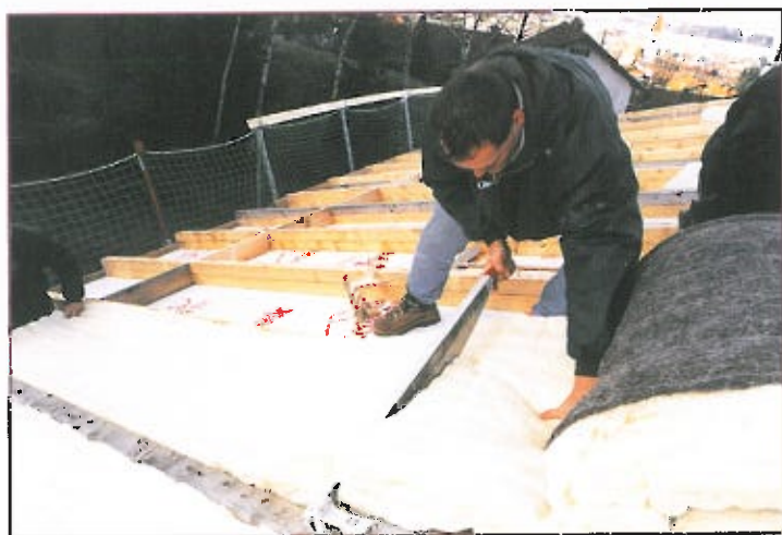
Schapenwol als isolatiemateriaal in een dakconstructie
